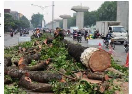
Abattage des arbres pour la construction de la ligne de métro Cat Linh - Ha Dong (Hanoi). Crédit photo : NGUYEN Huong
