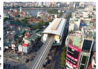
Vue de la station Thai Ha aérienne (la ligne 2A en cours de construction). Crédit photo : baomoi.com
